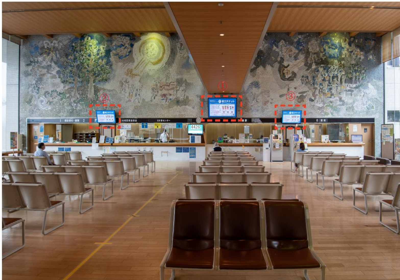
現在のモニター設置状況〈1階中央待合ホール〉① 80 インチ、②、③ 55 インチ
